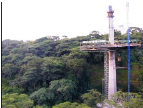
Figura 10. Presión dentro del fragmento, infraestructura humana
