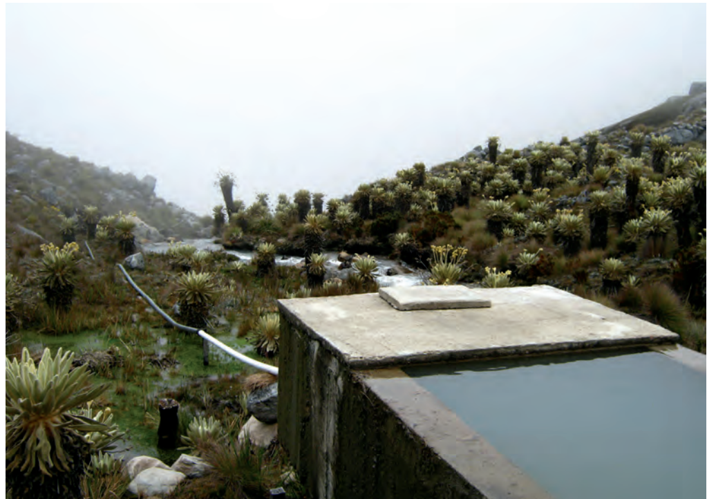
Figura 14. Bocatoma del acueducto Cóncavo-Coveñas, vereda Tabor, municipio de Guicán, Boyacá. Las veredas sirven también para definir espacialmente el alcance de la cobertura de los servicios que, como el agua, se extraen de los páramos. En ese sentido, buscar coincidencias entre el límite de los páramos y los límites veredales induciría a un manejo acertado y participativo de las funciones ecosistémicas que vienen de esos ecosistemas.
