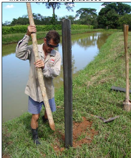
Figura 32. Instalación postes plásticos
