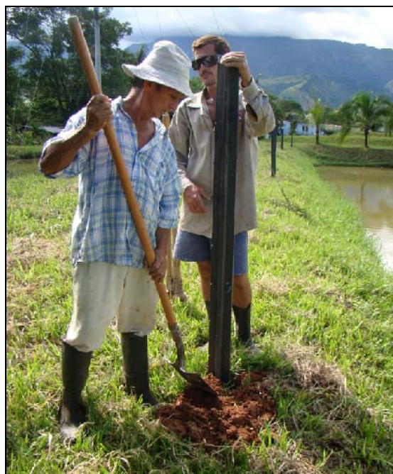
Figura 32. Instalación postes plásticos
