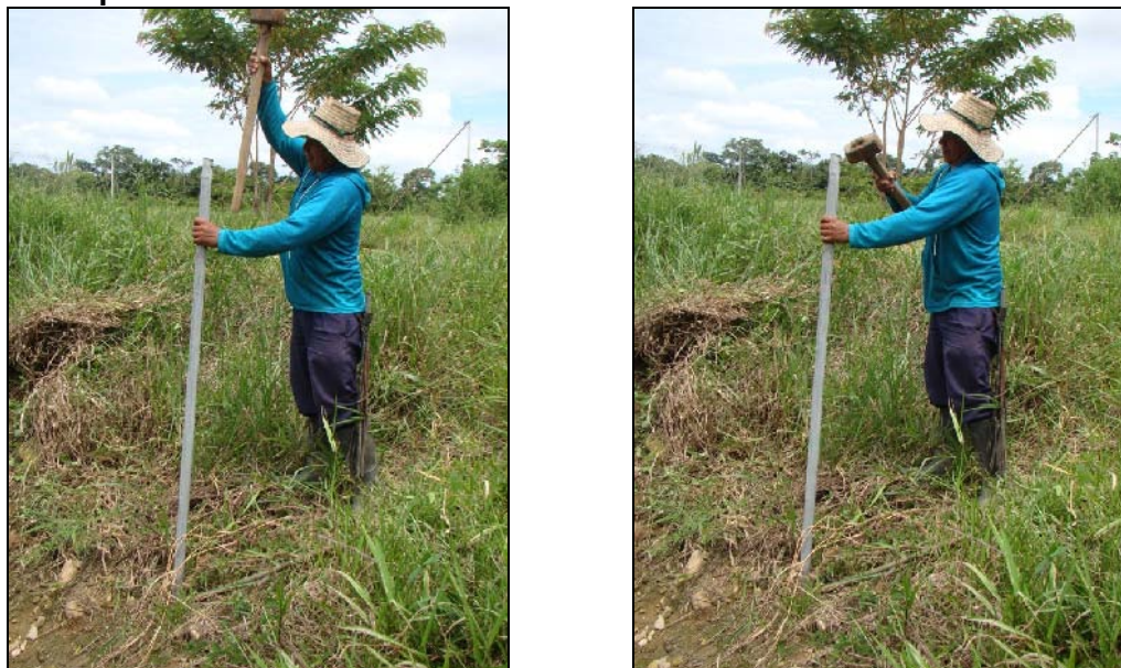
Figura 25. Instalación postes cada 10 mts.
