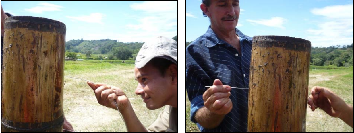
Figura 7. Instalación alambre entre agujeros guadua
