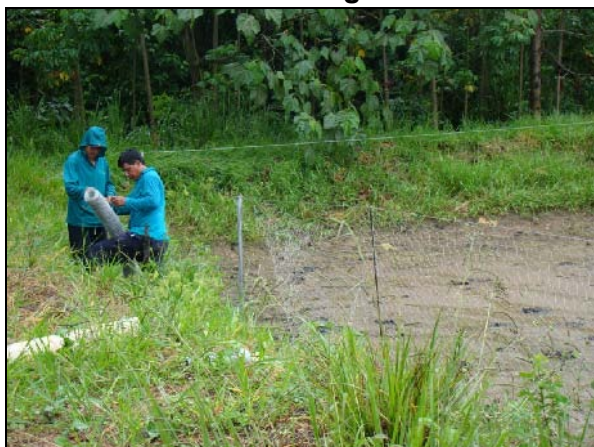
Figura 26. Instalación malla de gallinero
