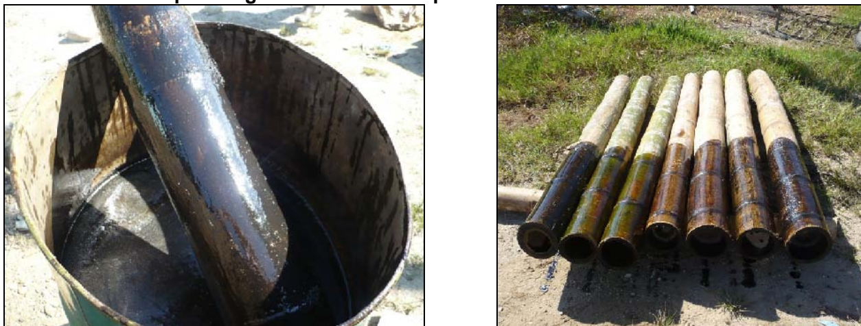
Figura 5. Inmunización postes guadua con aceite quemado
