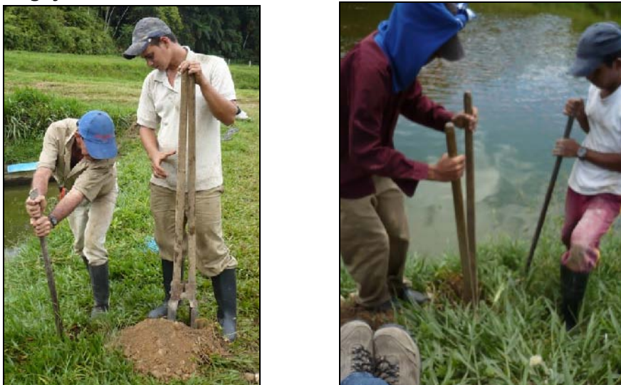
Figura 3. Realización agujeros externos e internos
