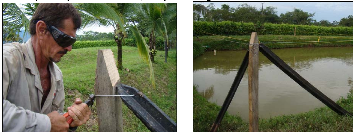
Figura 33. Reemplazo a postes de madera, con pie de amigo
