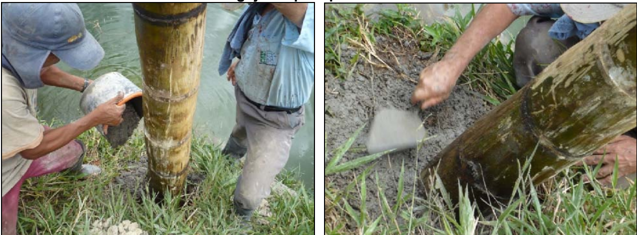
Figura 8. Vertido mezcla de cemento agujeros para postes internos
