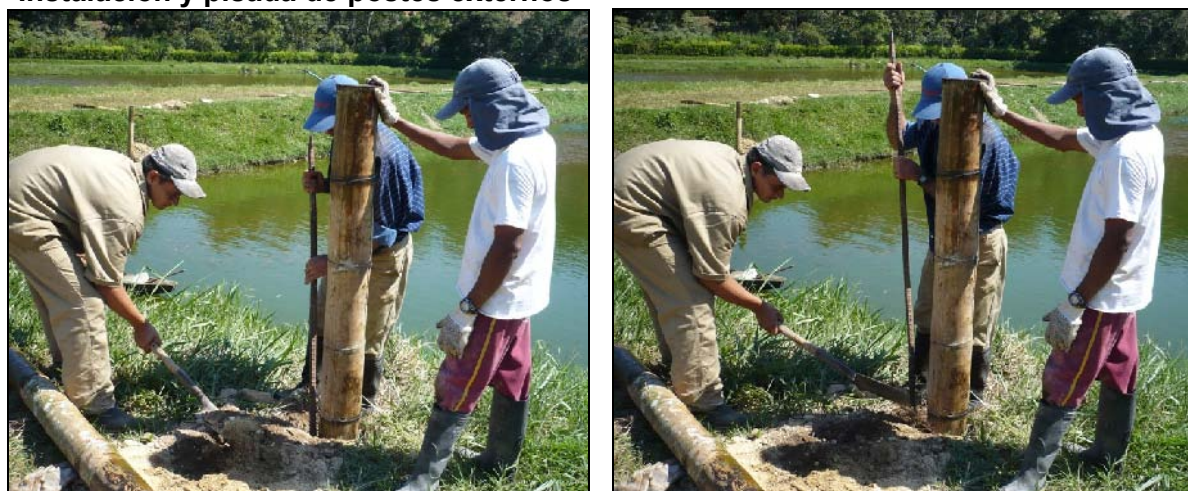
Figura 6. Instalación y pisada de postes externos
