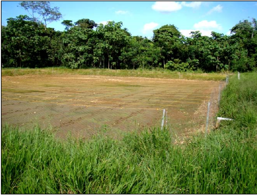
Figura 28. Instalación completa finalizada
