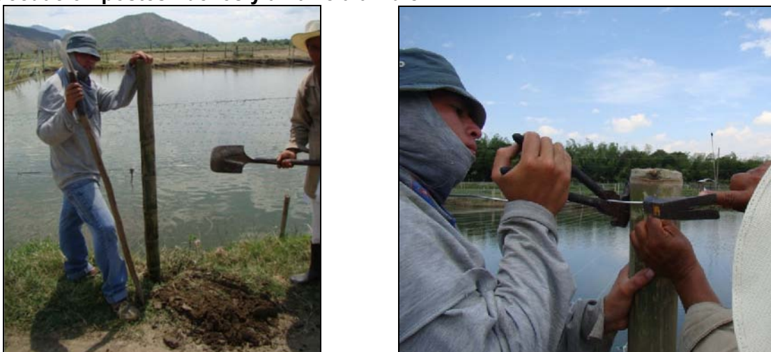
Figura 18. Adecuación postes nuevos y amarre alambre Instalación encordado (lado angosto)
