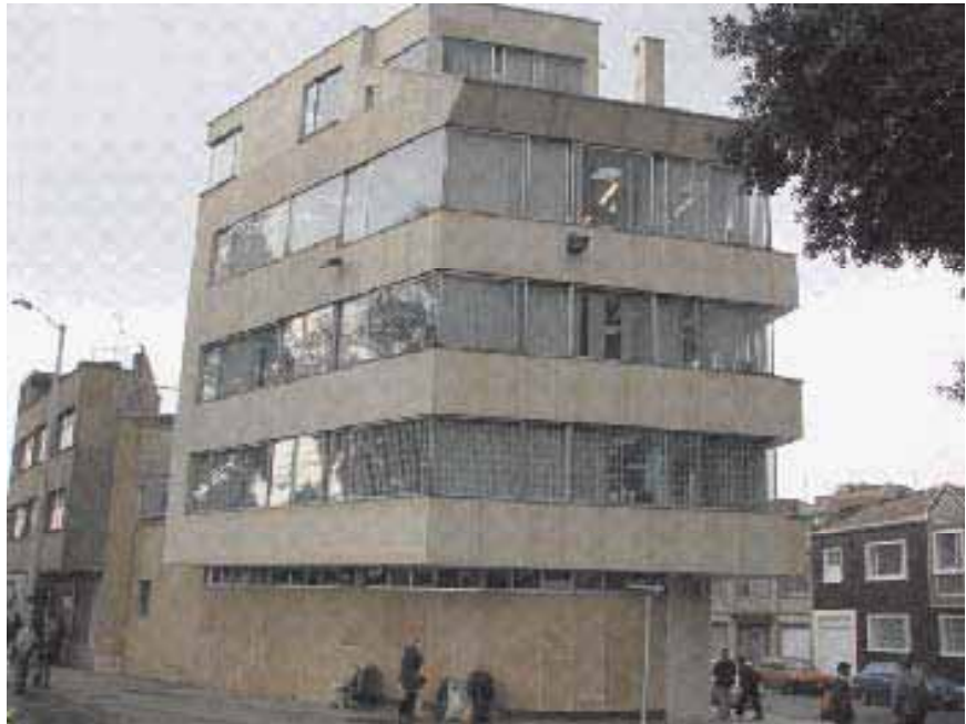
Figura 30. Fachada edificio sede principal
