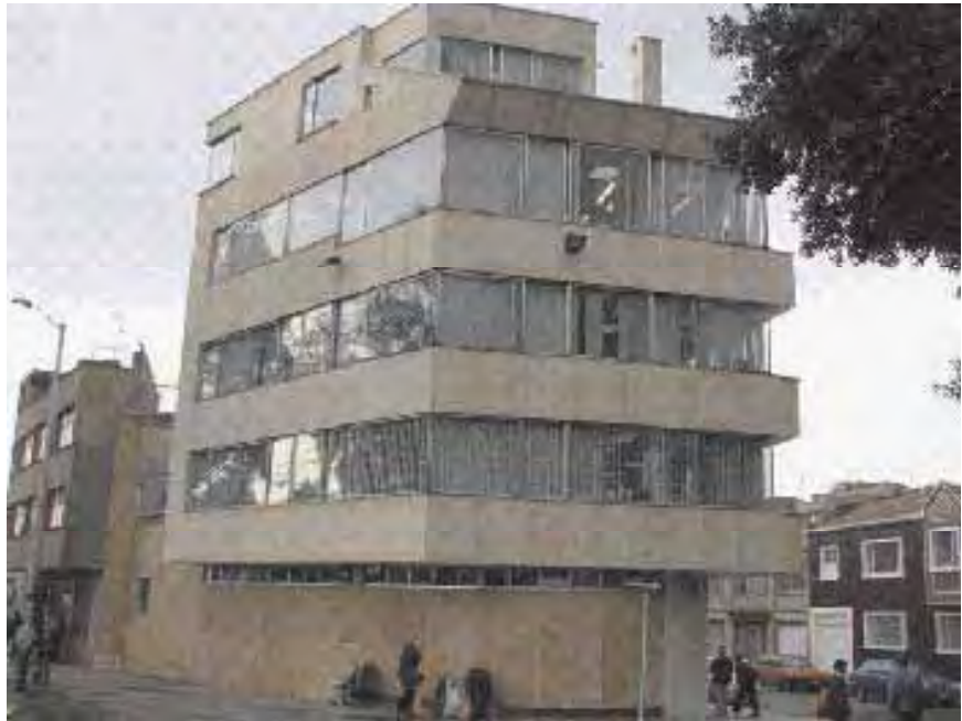
Figura 30. Fachada edificio sede principal
